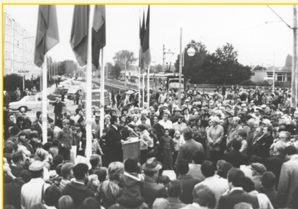
Die erste Straßenbahn fährt in die Rheinstrandsiedlung
