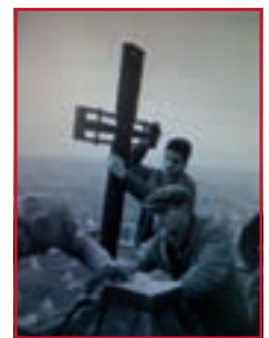
Dachreparatur auf dem Turm der Heilig-Geist Kirche
